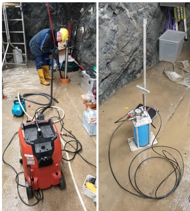
Obr. 14 Odčerpání vody nad pakrem, (vpravo) instalovaný hydraulický pakr
