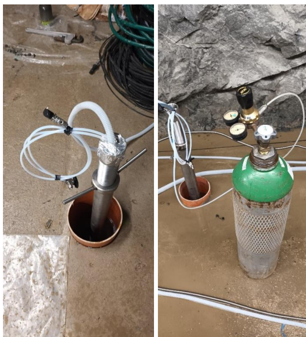
Obr. 18 Instalace a testování odběrového systému podzemní vody pomocí argonu
