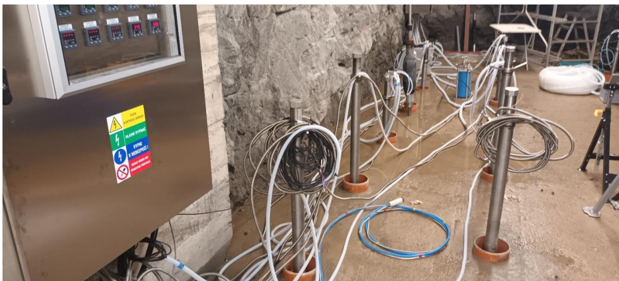
Obr. 22 Instalované sestavy korozního experimentu včetně systému monitoringu a regulace vytápění
