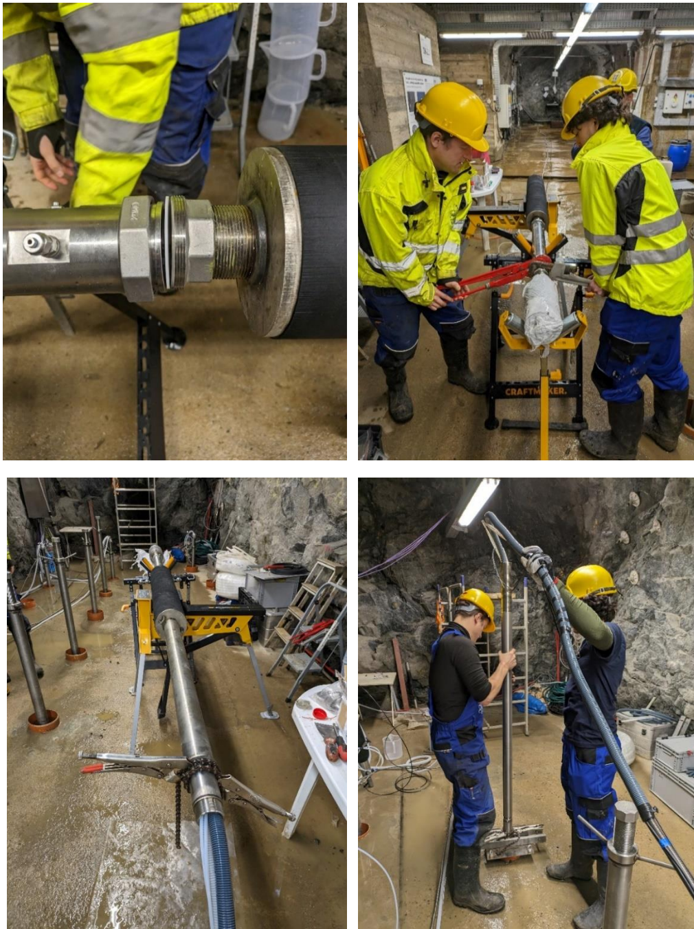
Obr. 17 Instalace korozních modulů za použití „rozšroubovaných“ pakrů
