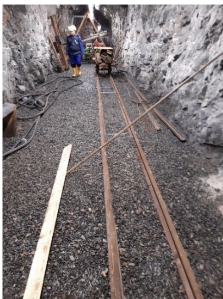
Obr. 4 Příprava chodby ZK-2, instalace kolejí Obr. 5 Instalace vrtné soupravy v komoře ZK-2
