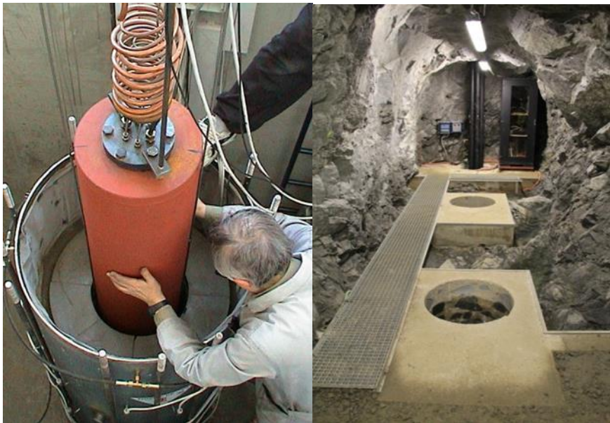
Obr. 9: Instalace topného tělesa do bentonitových prefabrikátů v projektu Mock-up1 a obrázek z Mock-up instalovaného v URC Josef
