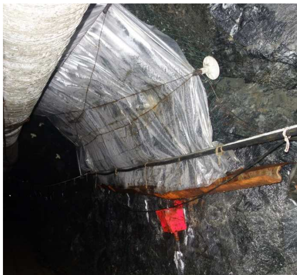
Obr. 132 Osazení přítoku BK31 sběrnou plachtou a žlabem
