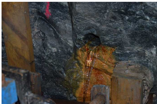
Obr. 117 BK27 Přítok z vrtu S-2 před instalací průtokoměru (vydatnost cca 1 l.s -1 )
