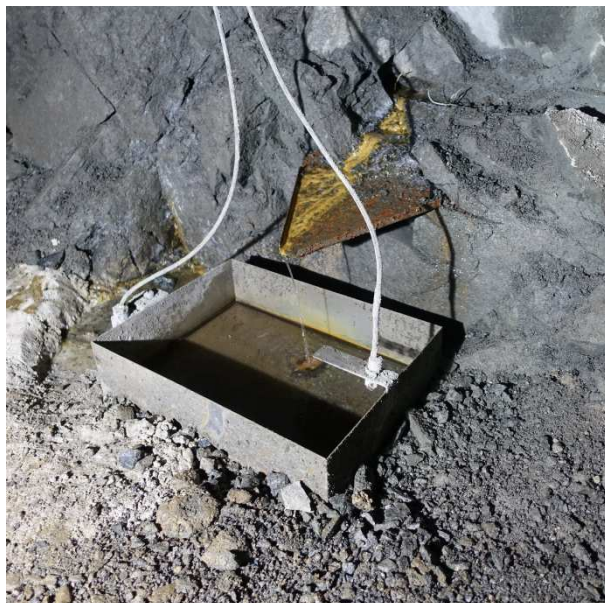
Obr. 131 Osazení monitorovaného přítoku BK23
