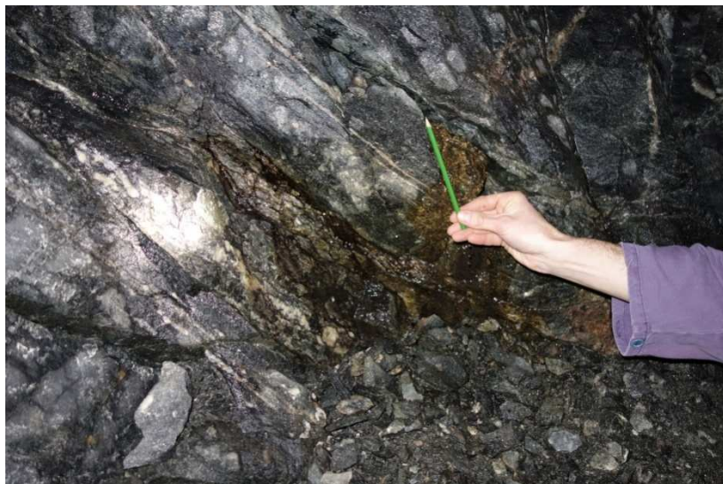
Obr. 115 BK03 průsaky na intersekci puklinového systému (směr spádnice/sklon 102/60) s křemennou žílou (330/80)
