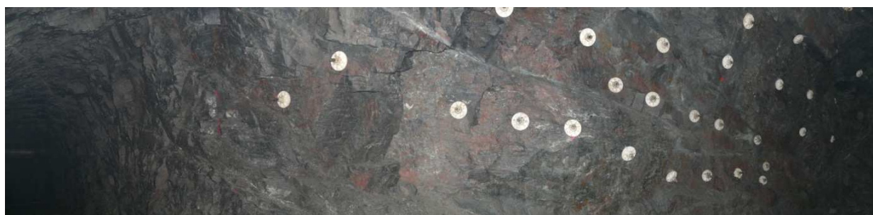
Obr. 51 Pohled na hematitizovanou poruchu procházející východní stěnou ZK-2, v délce cca 8 m
