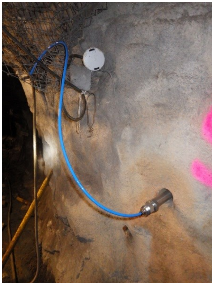
Obr. 9 Vrt S-22 utěsněný pomocí mechanického obturátoru s výtokem vyvedeným ca. 1 m nad ústím vrtu (ustalování podmínek)
