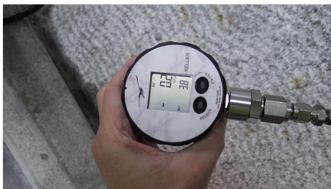
Obr. 6-8 Manometr použitý pro měření tlaku podzemní vody pod mechanickým obturátorem ve vrtu 15.002
