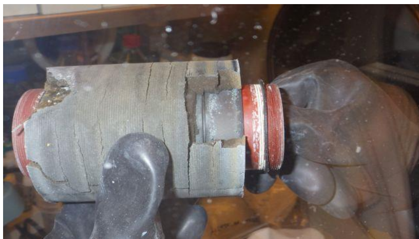
Obr. 7-6 Šedočerné zbarvení vnější strany bentonitu u modulů s uhlíkovou ocelí. Horní obrázek ukazuje stranu bentonitu přilehlou k uhlíkové oceli a v oblasti lomu bentonitu je pozorovatelné šedočerné zbarvení na vnější straně. Spodní obrázek ukazuje bentonit MX-80 z vnější strany
