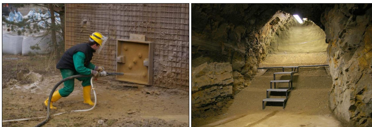
Obr. 8 - VLEVO: zkušební nástřik do odběrných prstenců a VPRAVO: Model zastříkání přístropí v podzemní laboratoři Josef
