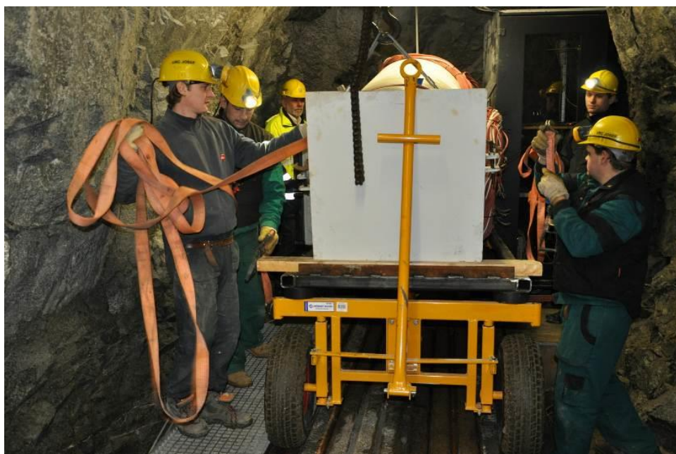
Obr. 24 - Model při přípravě pro vyjmutí z přepravního rámu.
