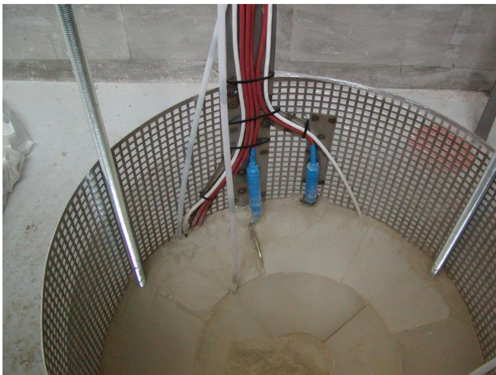
Obr. 11 - Podložení kabelů od monitoringu nerezovými plechy (ochrana proti protlačení kabelů a případnému porušení o hrany děrovaného pláště).
