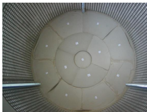
Obr. 13 - Rozměry bentonitových prefabrikátů v mm ve vodorovném řezu vlevo a vpravo foto z výstavby první vrstvy bentonitových prefabrikátů.
