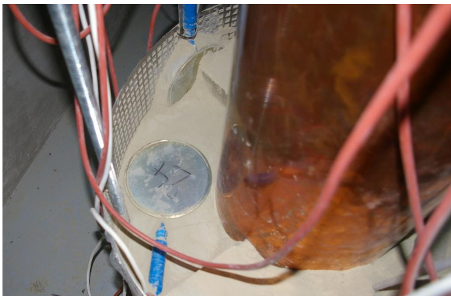
Obr. 36 - Hydraulická tlaková buňka (označení 24) umístěná ve II. měřicím profilu na povrchu bentonitového prefabrikátu.
