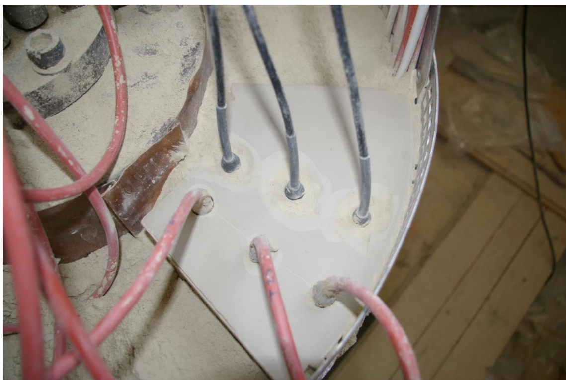
Obr. 40 - Svislé umístění Rotroniců (černé kabely) po šířce vodorovného profilu v bentonitovém prefabrikátu. Červené kabely jsou k teplotním čidlům.
