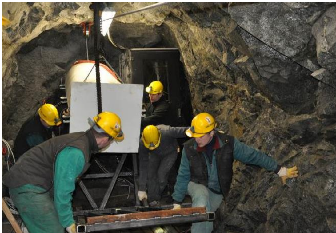
Obr. 25 - Vyjmutí přepravního rámu.
