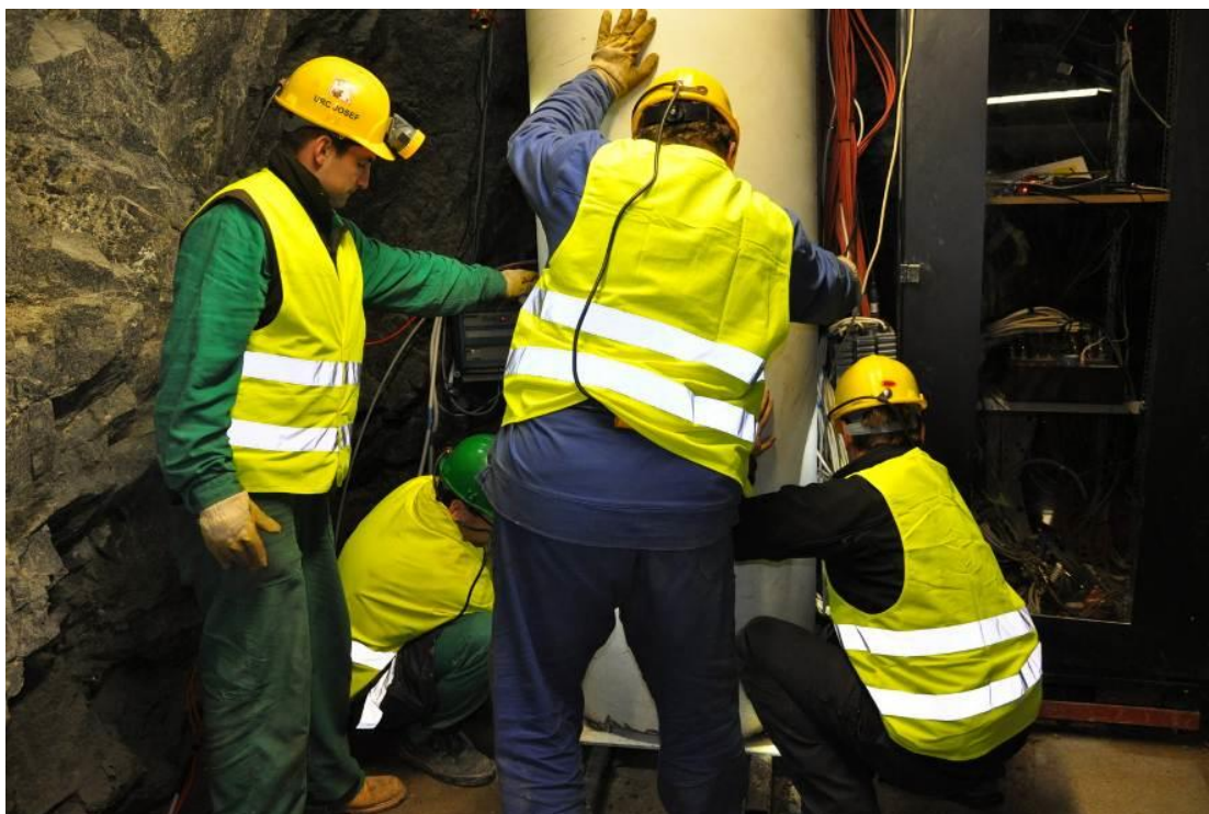
Obr. 29 - Sejmutí ochranného přebalu z modelu.
