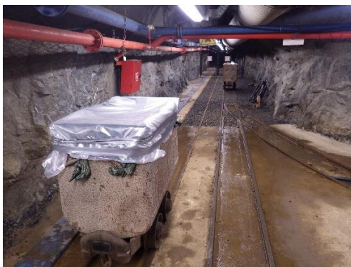
Obr. 300 Odběr vody z vrtu S1 do PE plachty pro vrtné práce (chlazení vrtné korunky)
