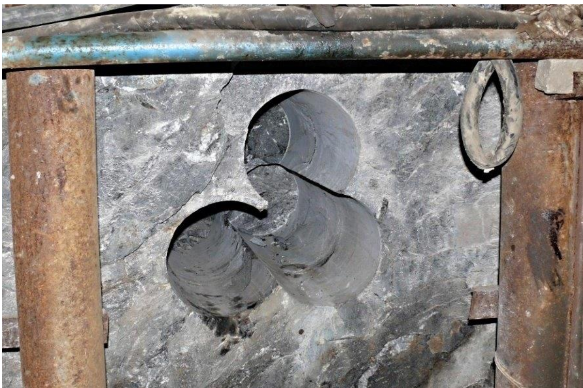
Obr. 19 Návrtky po vrtání velkoobjemových vzorků o průměru 300 mm v geotechnické stanici GS18 na 18. patře jámy R-7S, překop V 3 -XVIII. 18. 10. 2018
