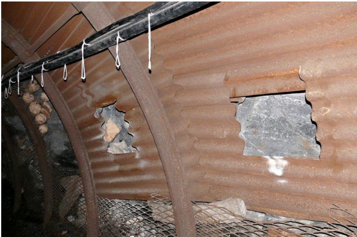
Obr. 15 "Geologická okna" pro výzkumné účely. Částečně odstraněný zátah z vlnitého plechu a tzv. "pakování" (založené volné prostory mezi TH-výztuží a horninou). 20. patro jámy R-7S, podložní chodba. PŠ1-203. 16. 8. 2018
