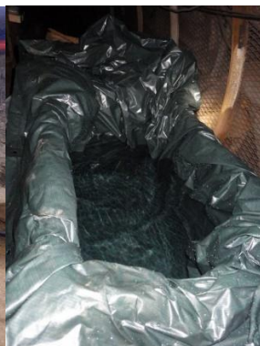
Obr. 300 Odběr vody z vrtu S1 do PE plachty pro vrtné práce (chlazení vrtné korunky)
