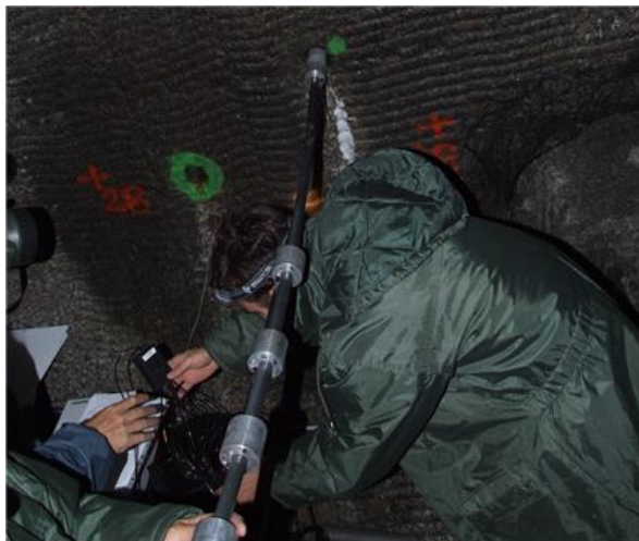
Obr. 65 instalace teplotního řetězce v jednom z horizontálních vrtů
