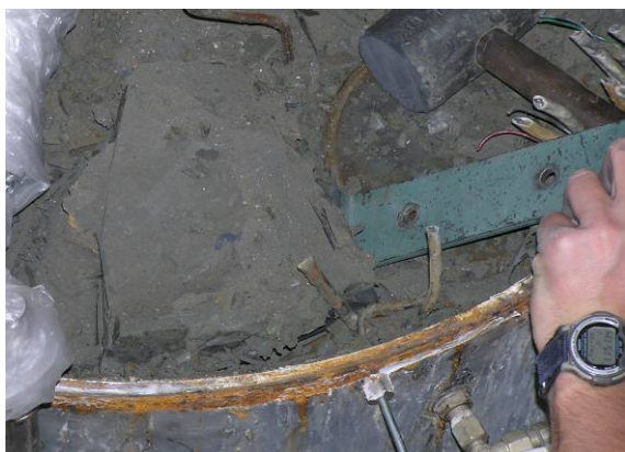
obr. 14 Mechanické rozpojování širokým dlátem
