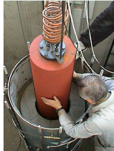
obr. 5 Spouštění topného tělesa do bentonitové bariéry
