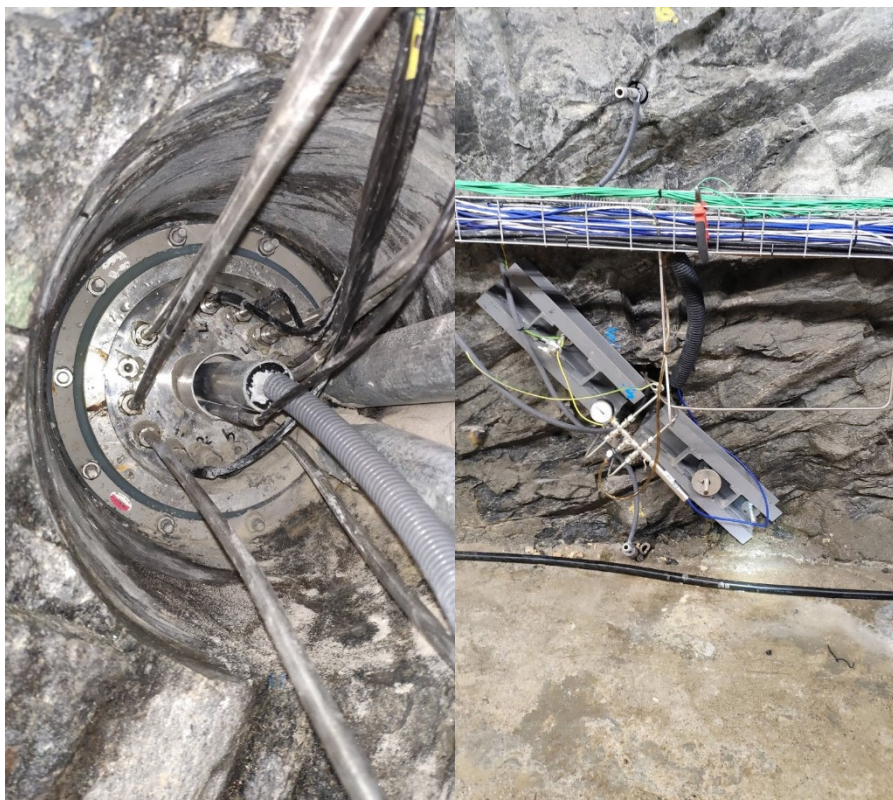
Obr. 12 Nové topidlo FM5 po instalaci
