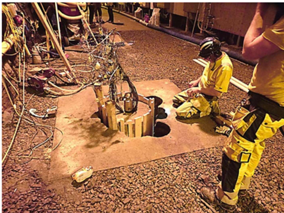
Obr. 30 Velké otvory vyvrtané jádrovým vrtáním, obklopené malými otvory vyvrtanými nárazovým vrtáním (Sandén a Nilsson, 2020)
