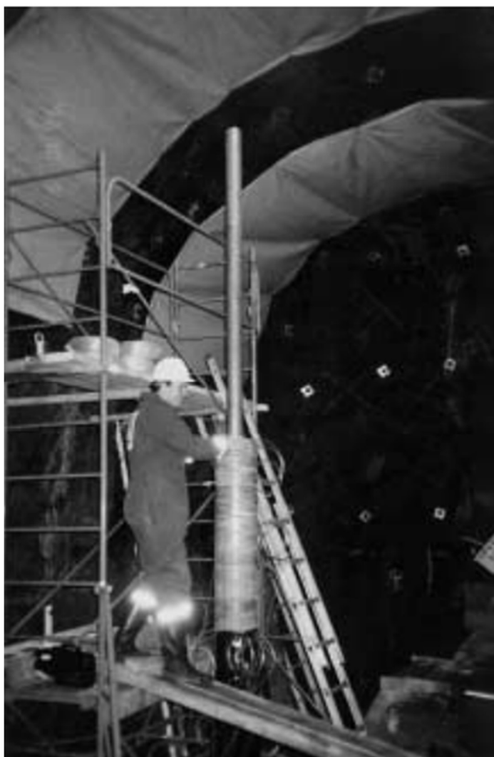
Obr. 29 Skládání kroužků bentonitu okolo měděné trubky experimentálního modulu (Karland et al., 2000)
