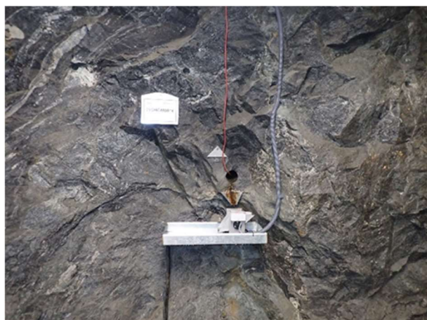
Obrázek 4 Ukázka instalace měrného bodu
