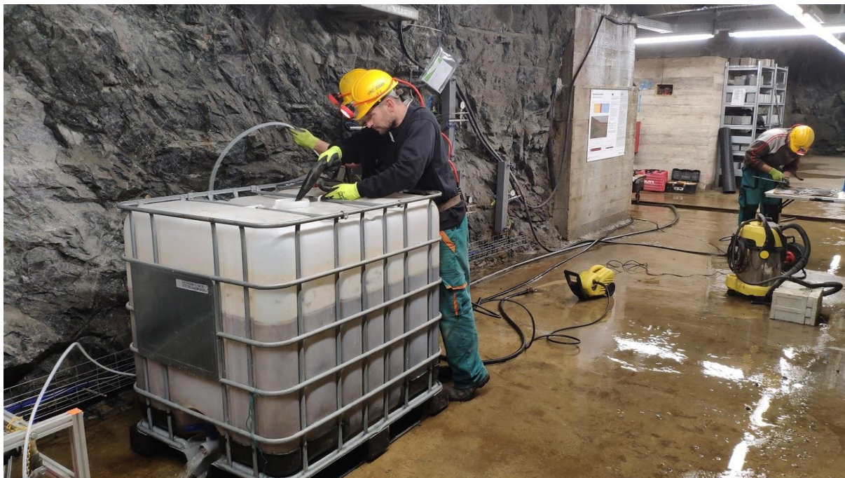
Obr. 3 Čištění nádrže tlakovou vodou
