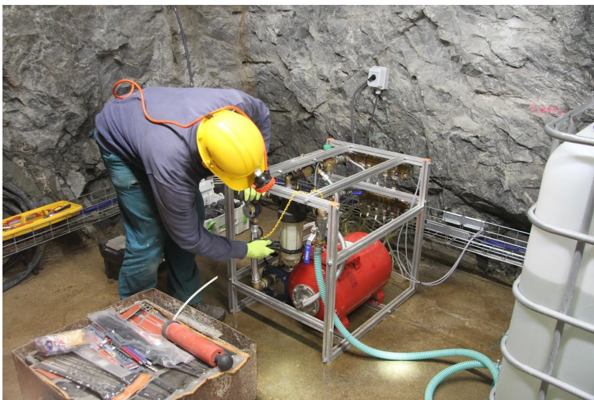
Obr. 2 Údržba tlakovacího systému
