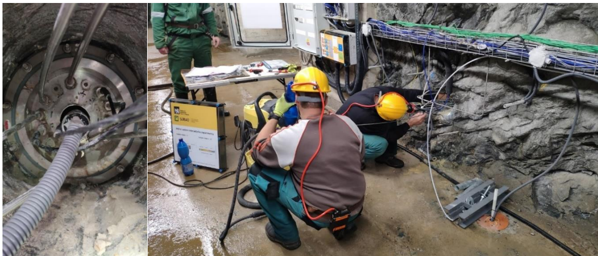
Obr. 8 Výměna obsypu topidla FM5
