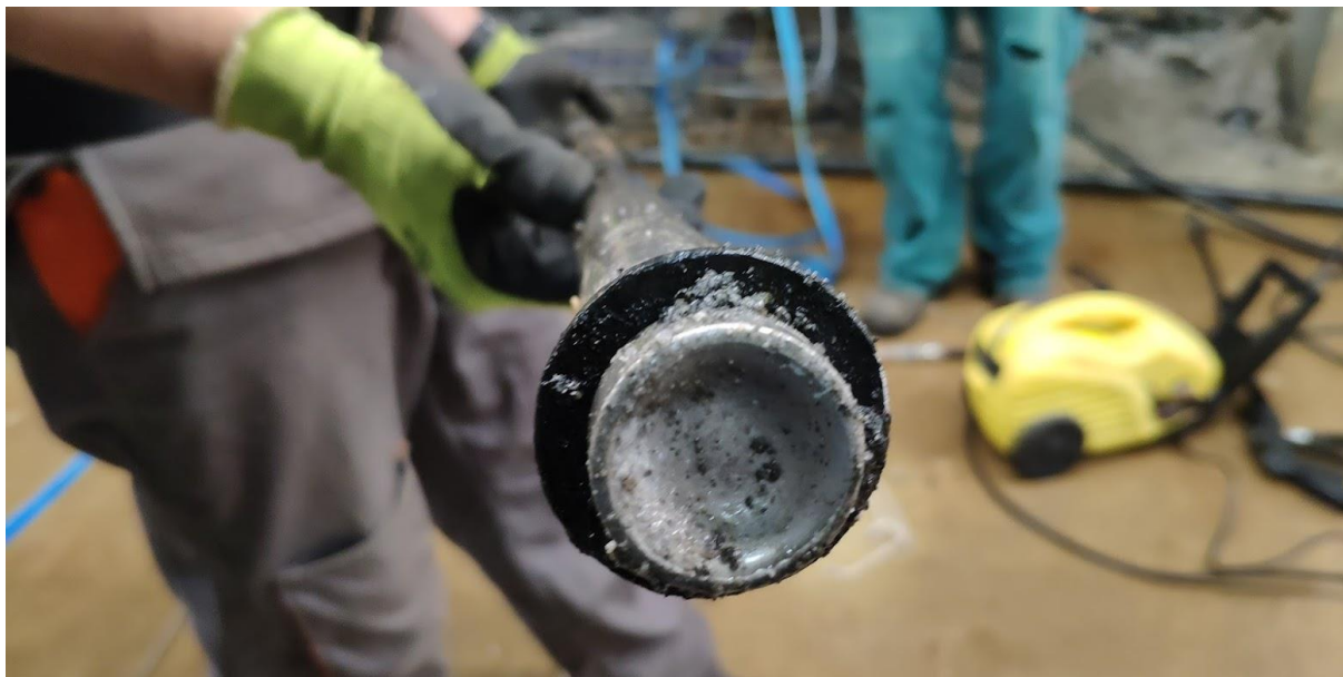
Obr. 10 Pohled na vyjmuté "nové" topidlo (10.8.2021)
