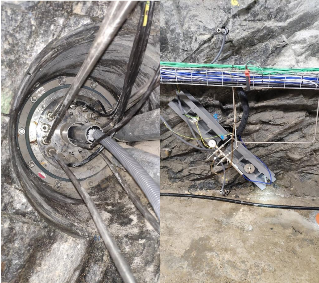
Obr. 7 Nové topidlo FM5 po instalaci (4.3.2020)
