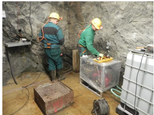
Obr. 4 – Instalace čerpadla
