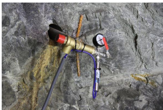
Obr. 35 – Piezometr osazený na S19
