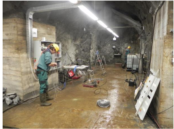
Obr. 2 – Zapojování instrumentace
