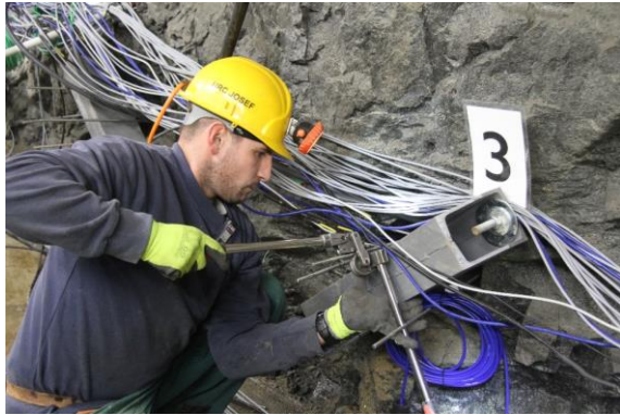
Obr. 27 – Příprava sytičícího systému zhlaví
