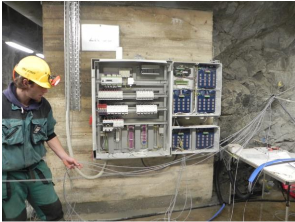
Obr. 1 – Instalace rozvaděčů a kabeláže
