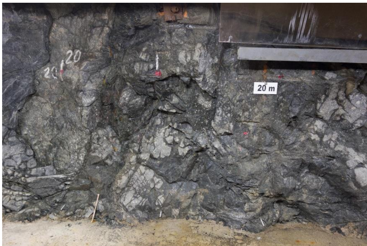
Obr. 51: Část stěny zkoumané chodby, staničení 20 m.
