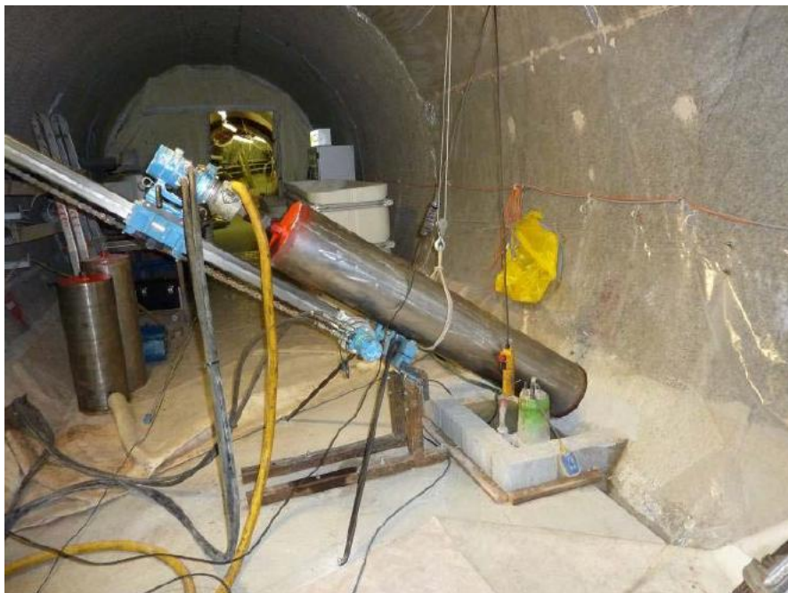
Obr. 15 Vrtná souprava při převrtání experimentálního vrtu LTD Phase I. v roce 2009
