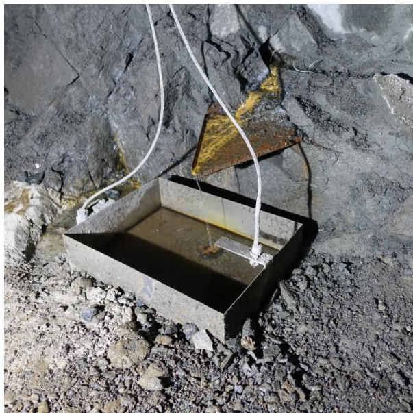
Obr. 131 Osazení monitorovaného přítoku BK23
