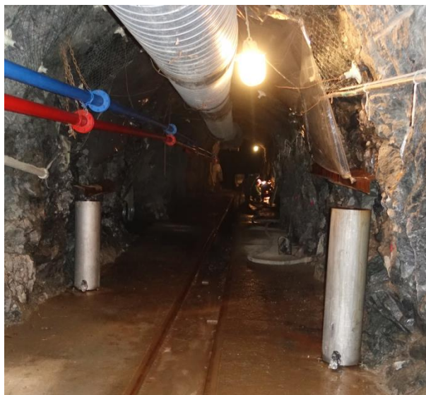
Obr. 133 Osazení přítoku BK32 měrnými válci
