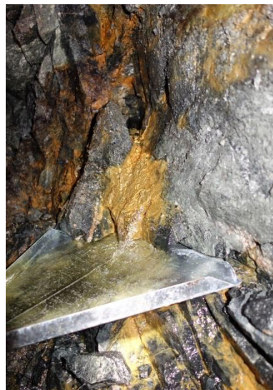
Obr. 116 BK06B vydatný výtok na křížení 2 systémů puklin (299/62 a 118/58)
