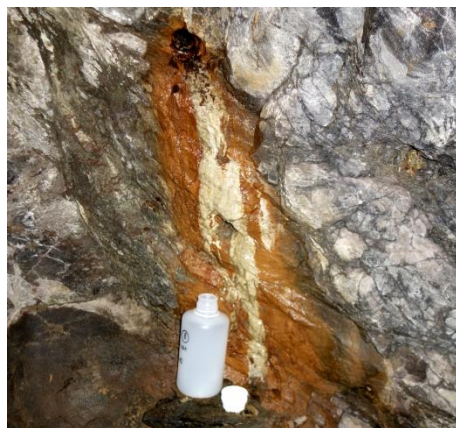
Obr. 124 BR08 výtok podzemní vody z průzkumného vrtu, 24. patro, PŠ1-243, jáma R7.
