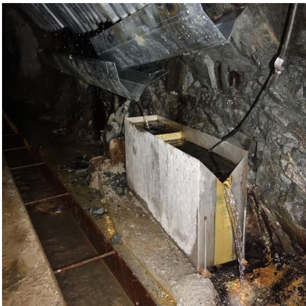
Obr. 130 Osazení monitorovaného přítoku BK06
