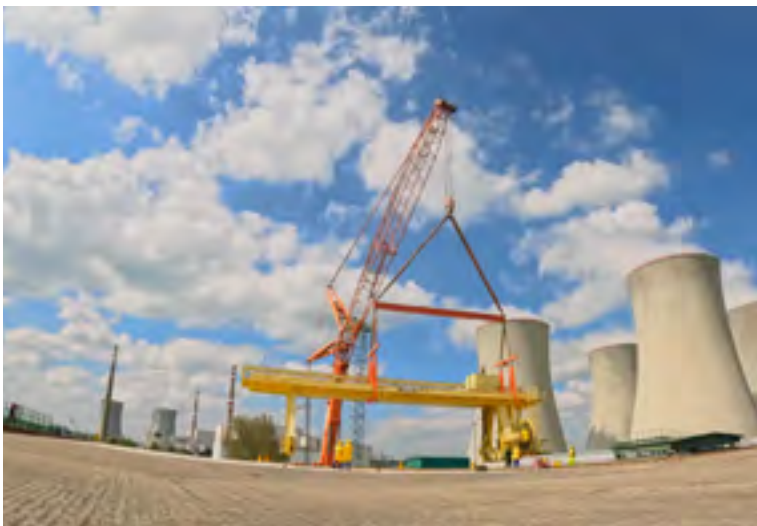
Úložiště radioaktivních odpadů Dukovany
